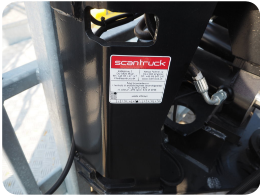
Eftersyns mærkat (Årlig inspektion)
